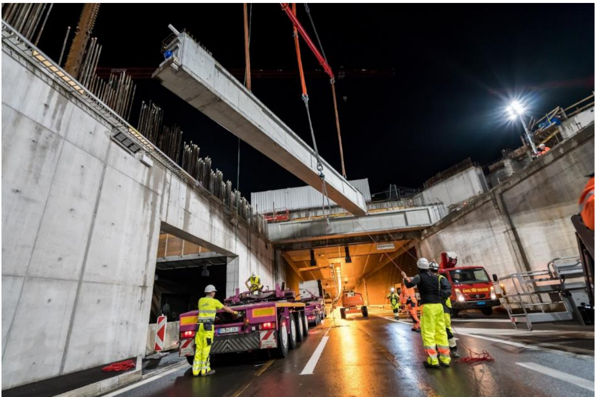
Bildauswahl Installation Spannbetonträger: Download
