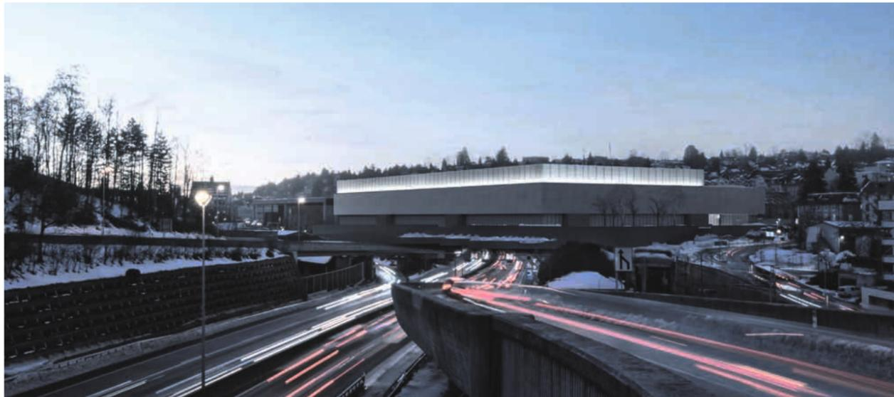
Die neue Halle steht auf einer Überdeckung über der Autobahn A1.
