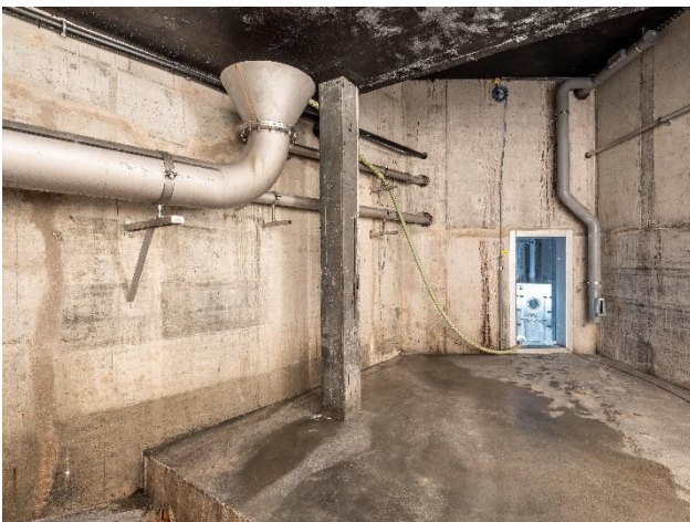
Kino Rex: Kinosaal als Regenrückhaltebecken
