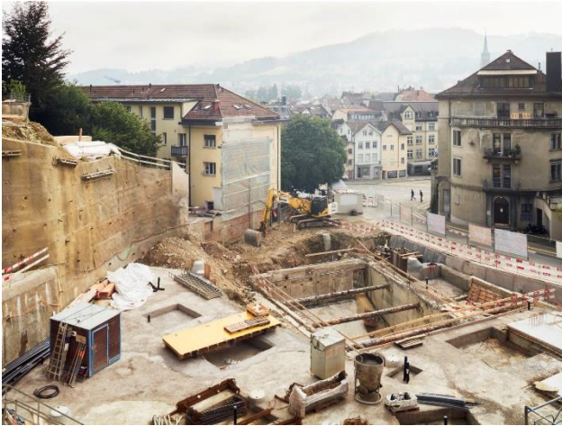
Kino Rex: Kinosaal freigelegt, Blick in Baugrube
